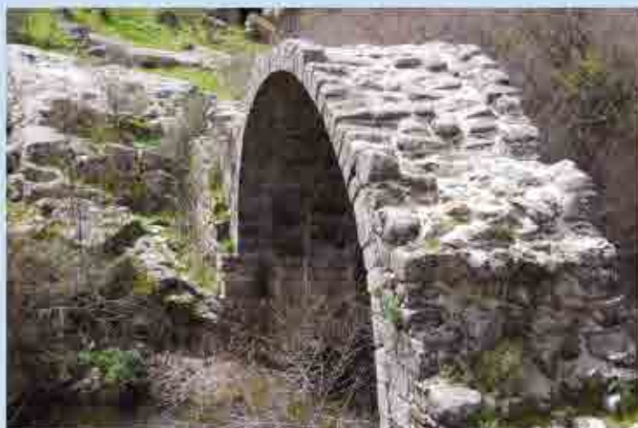
(3) PUENTE DE ALCANZORIA
