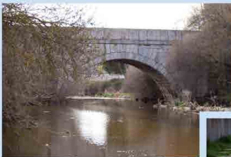
(4) PUENTE DE HERRERA
